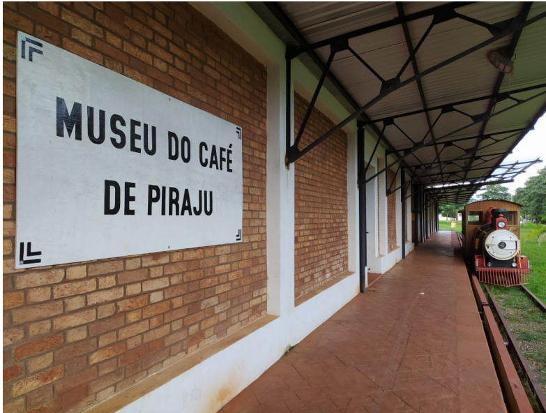
Figura – Vista parcial do prédio principal
