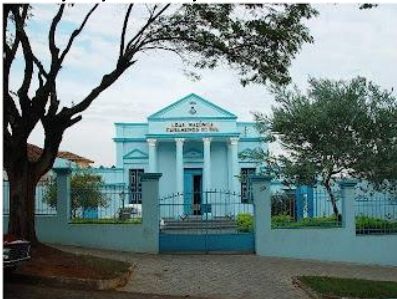
Figura – Vista parcial do prédio principal
