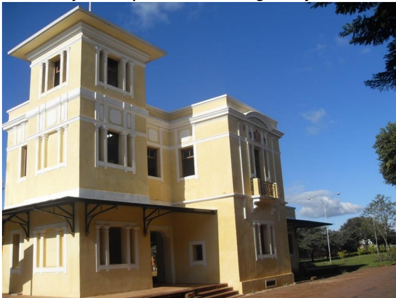
Figura – Vista parcial do prédio principal
