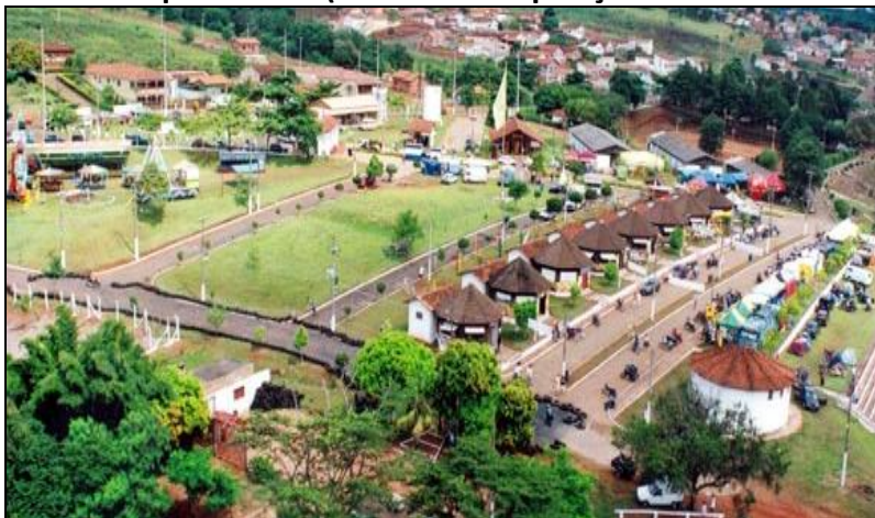
Figura – Vista aérea parcial do Parque FECAPI
