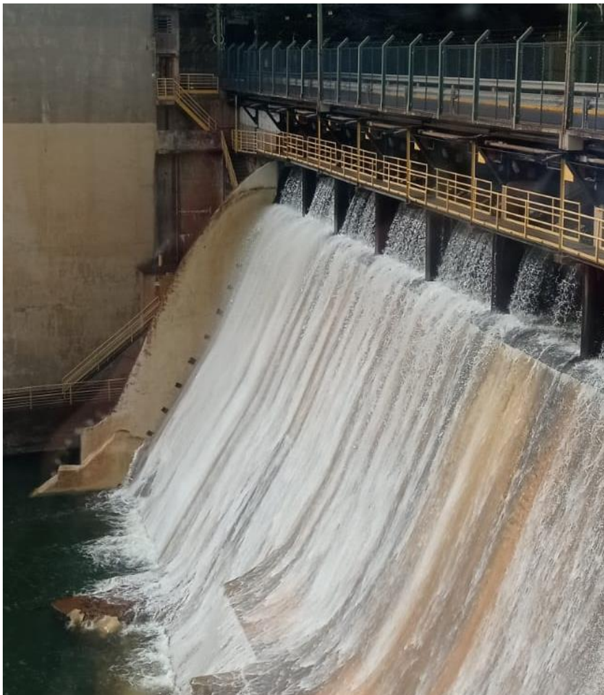
Figura – Vista parcial da queda d’água da Ponte Eng. Nelson de Godoy
