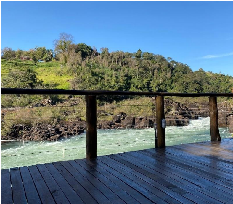
Figura – vista parcial de um dos decks.
